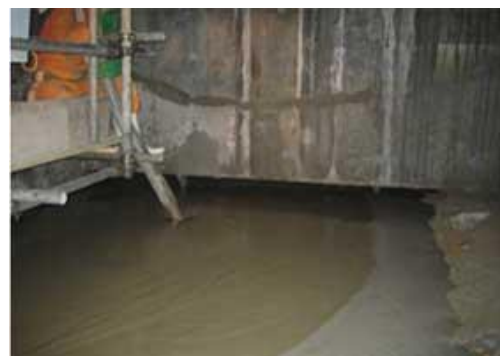
下水道不用管路の閉塞埋戻し
