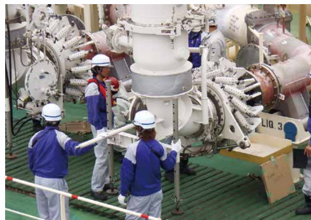
LNG荷役ローディングアームフランジ接続
