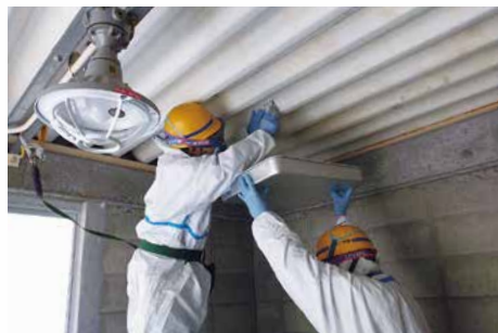
建材中の石綿試料のサンプリング
