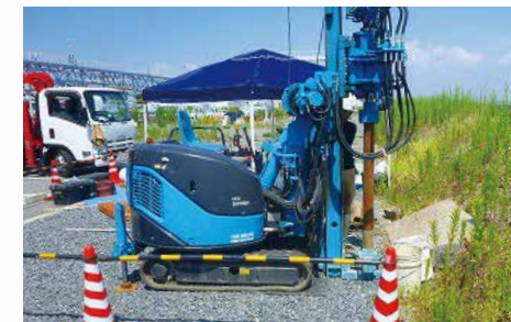
ボーリング調査
