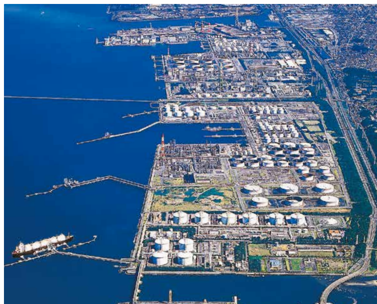
LNG基地とLNG船
