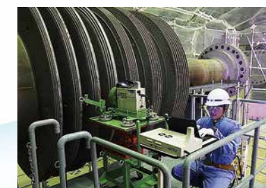
クリアランス測定(5号機タービンロータ)
