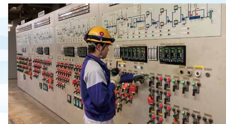
排水処理設備の運営業務
