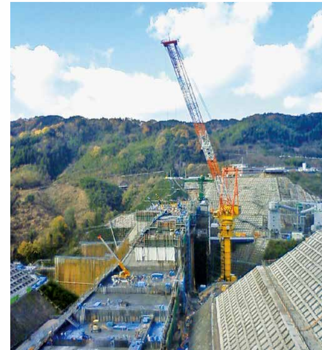
フライアッシュセメントを使用したダム工事
