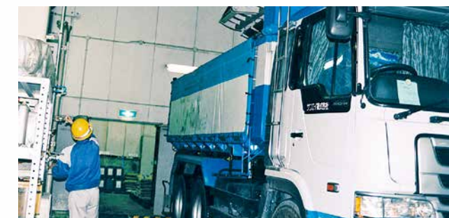
汚泥のトラックへの積み込み
