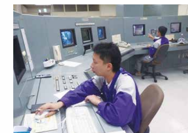
検査・搬出設備運転監視
