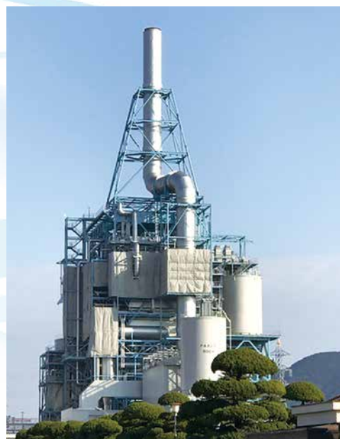
建設中のバイオマス発電所
