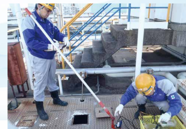
浄化槽の保守点検
