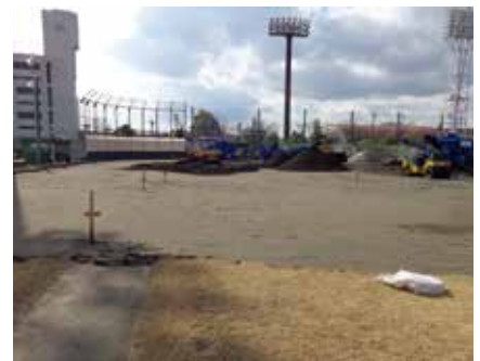
ランドラスを使用した野球場の施工状況
