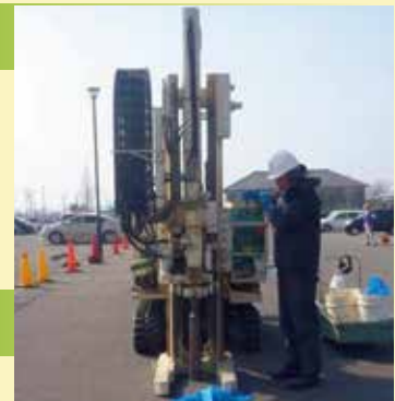
ボーリング調査
