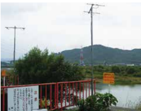
固定型アンテナでの調査
