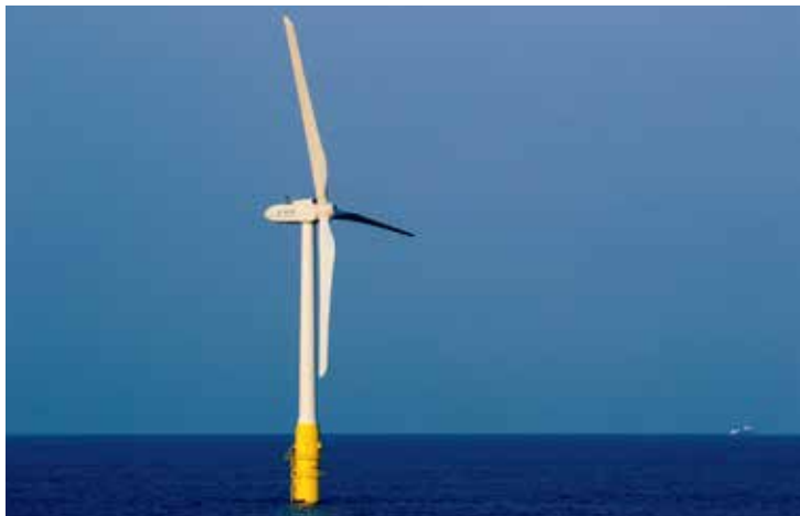
洋上風力発電所
