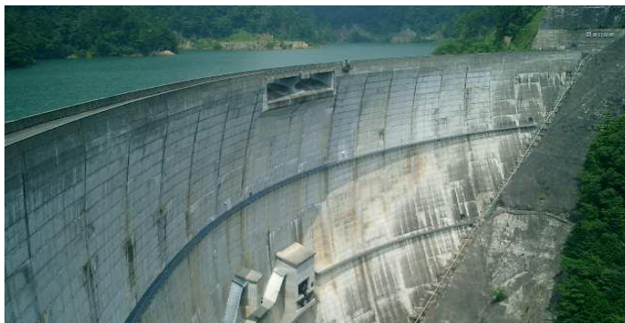
フライアッシュセメントを使用した 中部電力奥美濃水力・川浦ダム
