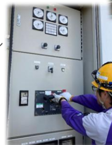
風車受変電設備の操作
