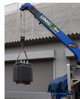
PCB廃棄物処分支援 (搬出状況)
