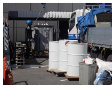
PCB廃棄物処分支援 (搬出状況)
