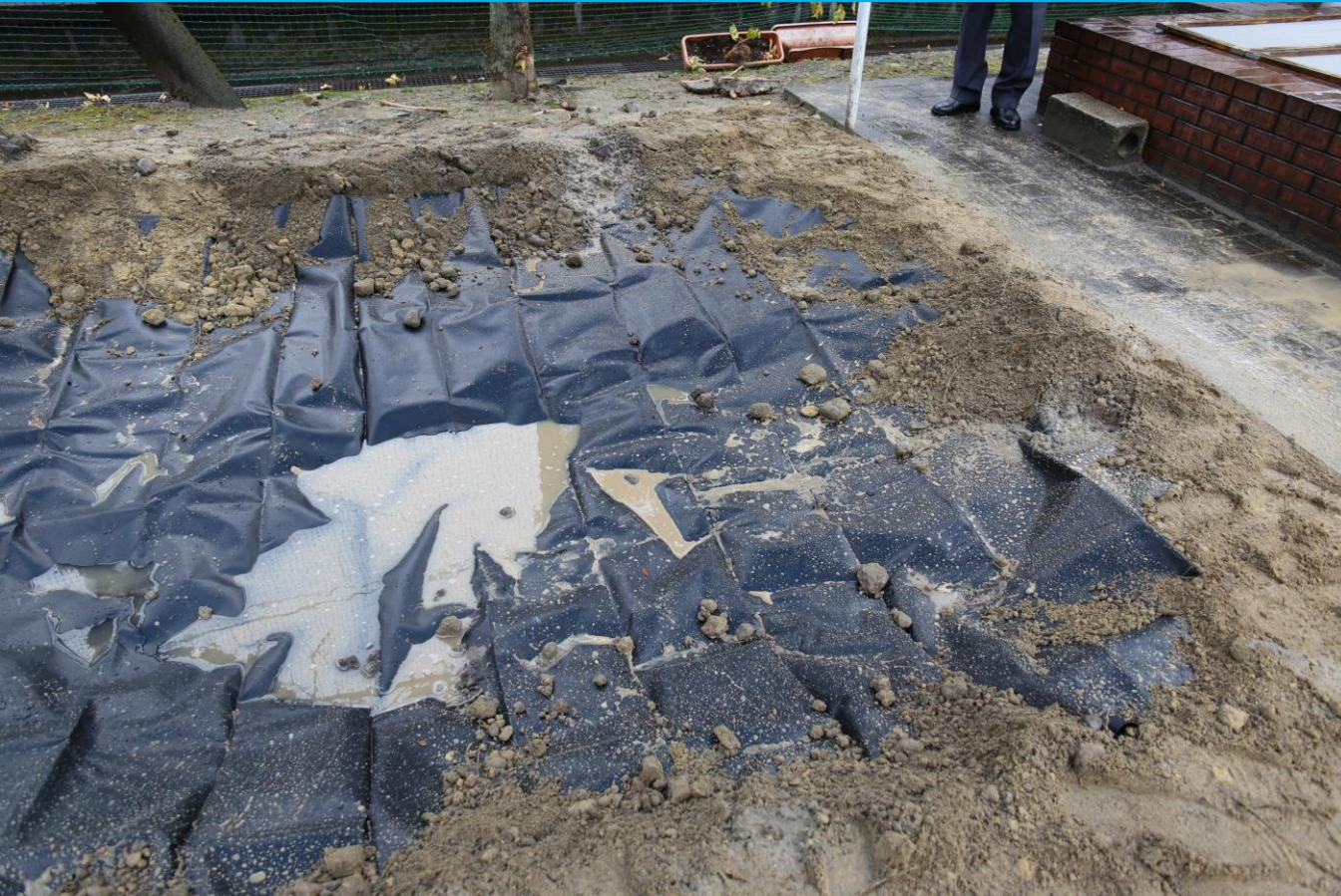
2日目は雨が降る寒い中での作業 掘削したビオトープ池に遮水シートを展張
