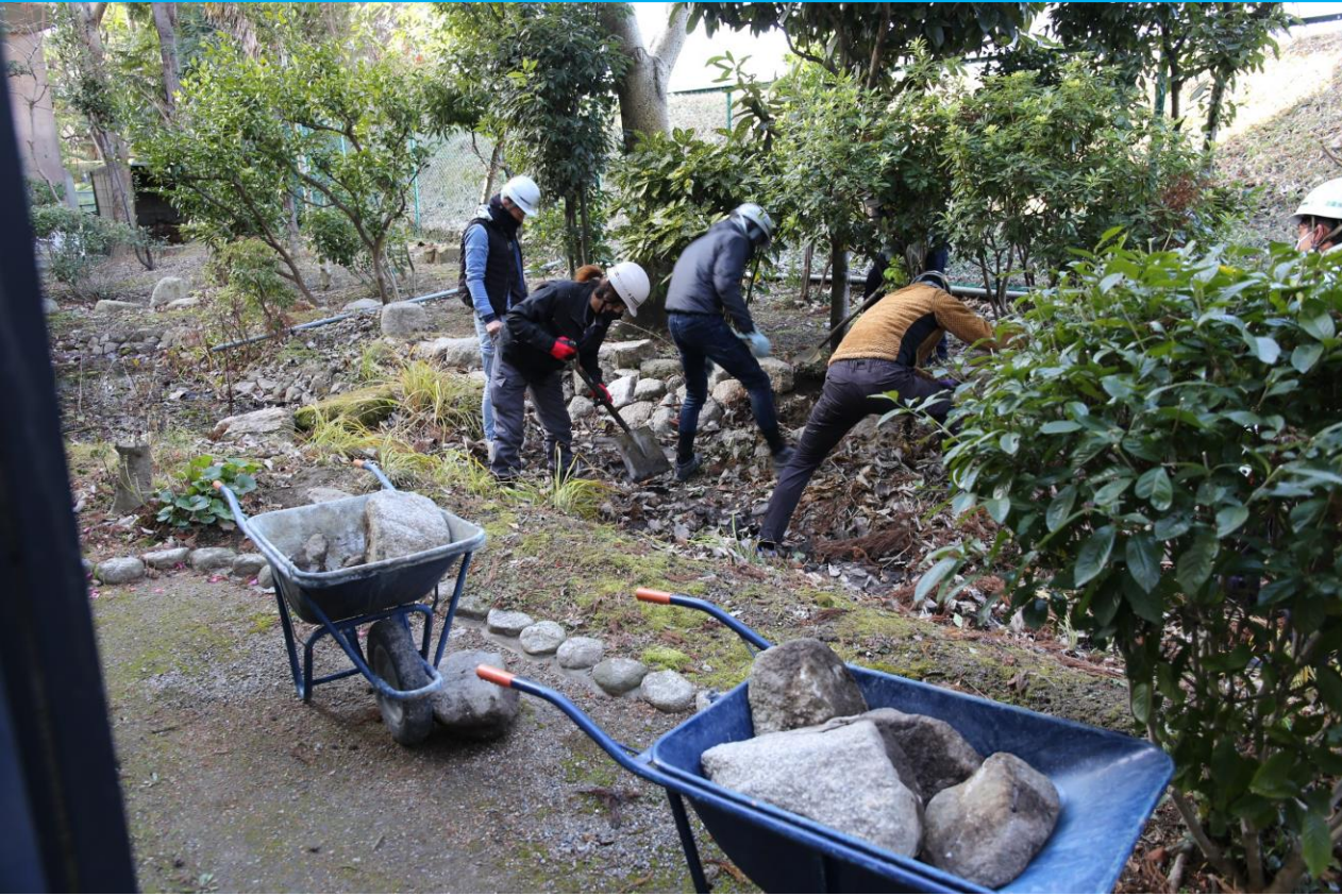
旧ビオトープの解体 再利用できる石の回収
