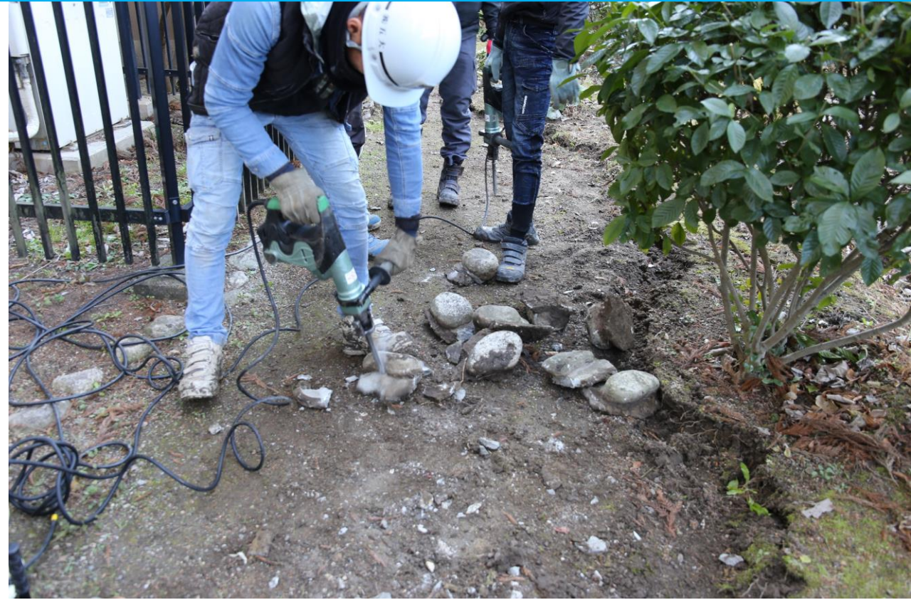
石に付着しているモルタルをチッパーで除去
